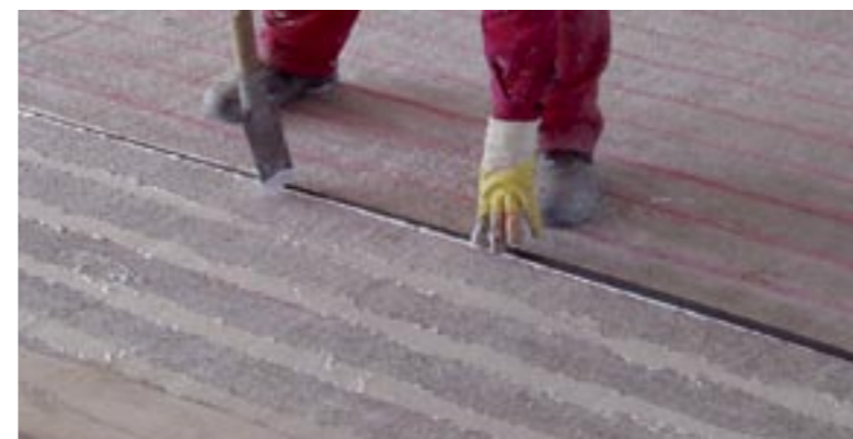
MC-DUR CFK-Lamelle lepené do drážek
