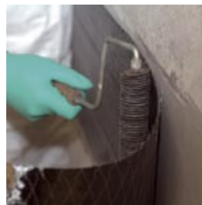
aplikace rohože pomocí laminovacího válečku
