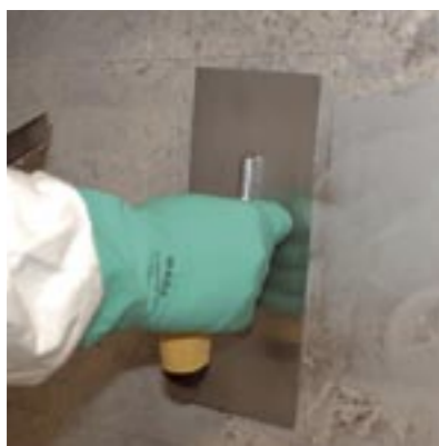
nanesení lepidla MC-DUR 1209 TX
