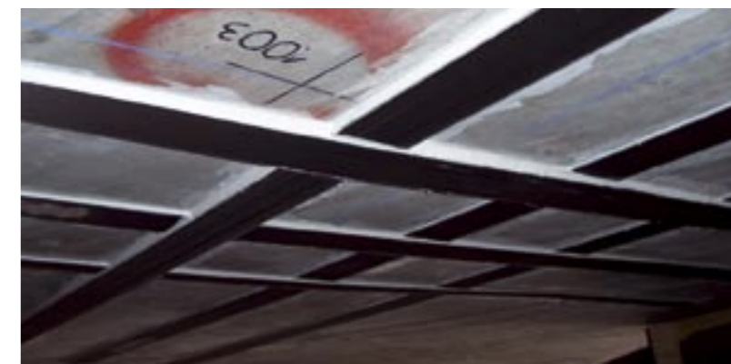
MC-DUR CFK-Lamelle lepené na povrch
